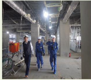
1階現場内視察状況
